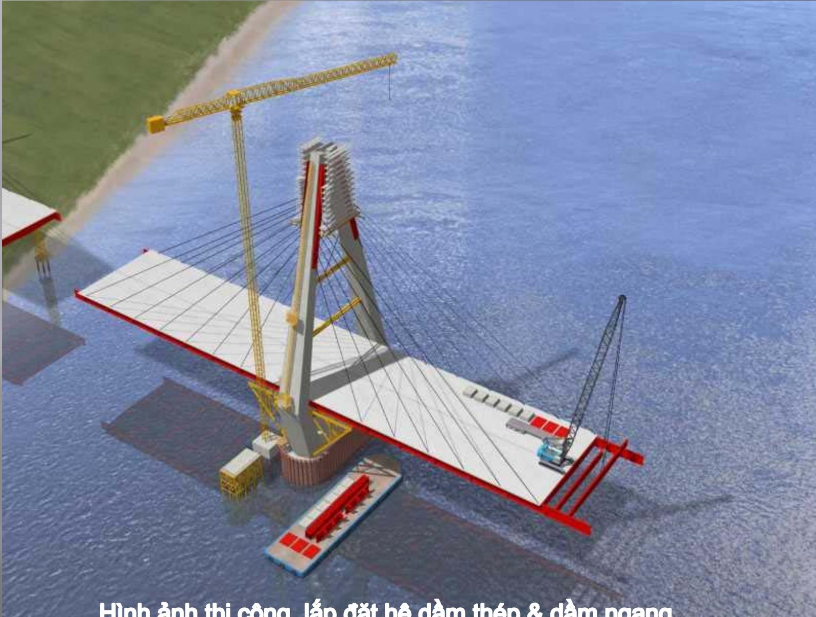
Hình ảnh thi công, lắp đặt hệ dầm thép & dầm ngang
